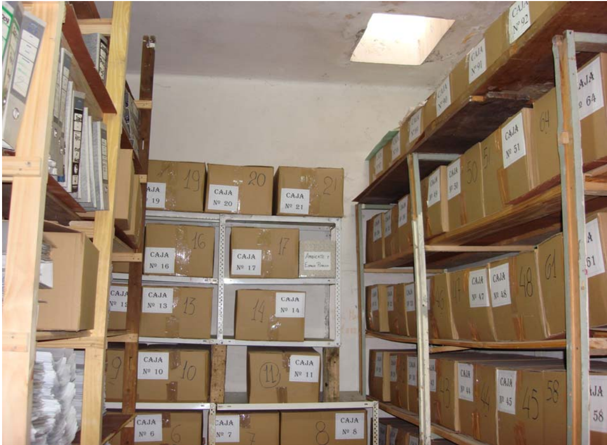
Foto Nro. 2 – En la presente vista se pueden ver en este lugar de la imprenta un sector cuyas estanterías fueron realizadas después de la última auditoría y es usado como depósito de documentaciones. Es de notar la presencia de humedad en el cielorraso cerca de una abertura para iluminación (lucarna).
