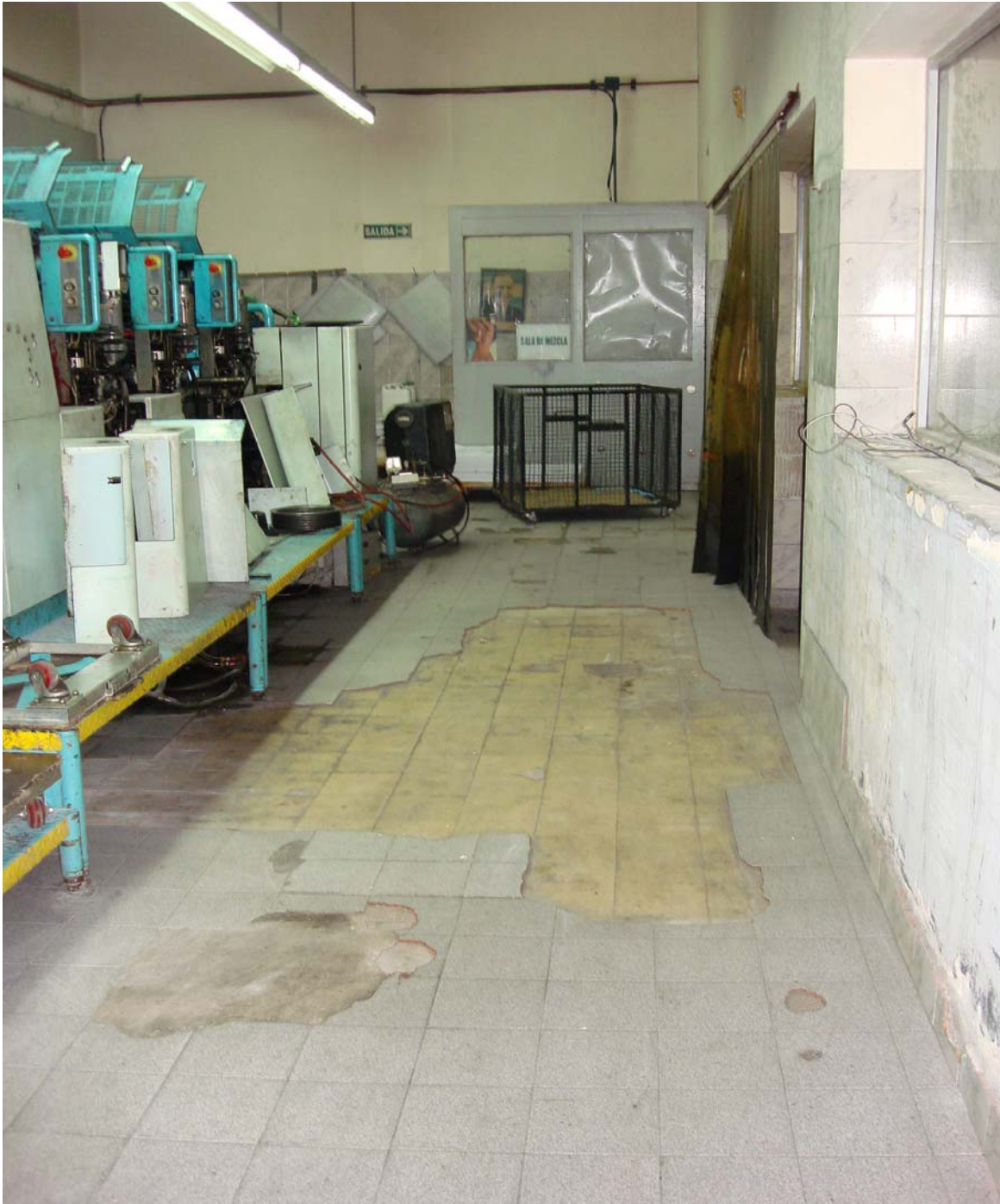
Foto Nro. 5 – En la presente vista se puede ver el piso del local donde está la impresora “Polly” .En este lugar podemos observar el solado de cerámica actual pegado sobre los mosaicos antiguos, es de notar que las cerámicas presentan algunas rotas, en varios sectores espacios vacíos de revestimientos y en algunas partes rellenos con un mortero de cemento y arena.
